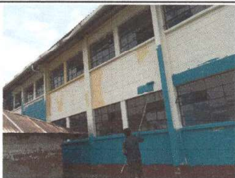
Foto 3: En esta fotografía se observa como va cambiando el edificio con la pintura nueva, esto con el apoyo de los padres de familia.
